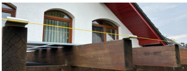
Obrázek 3 – Upevnění háčků do spodních nosníků
