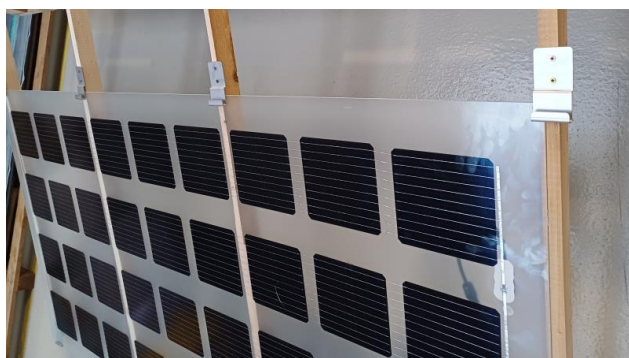
Obrázek 4 – Vložení panelu a zafixování panelu z horní strany
